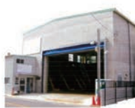
町屋資材センター
